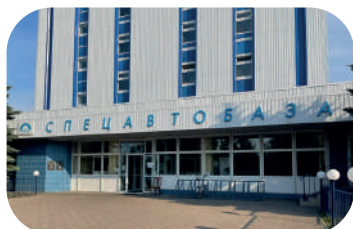
ГУП Водоканал, г. Санкт-Петербург
