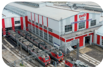
Ремонтное депо РЖД, г. Чита
