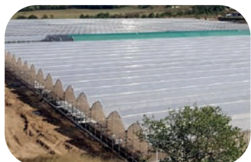
Теплицы СХП Кавказ, Ставропольский край
