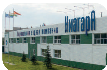
Производство воды Ниагара, г. Челябинск
